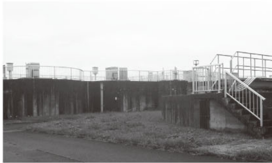
汚水処理を行う涌谷浄化センター
