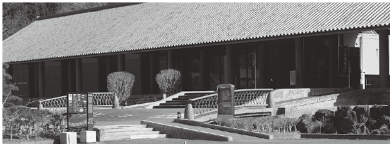
天平ろまん館の避難誘導灯を修繕
