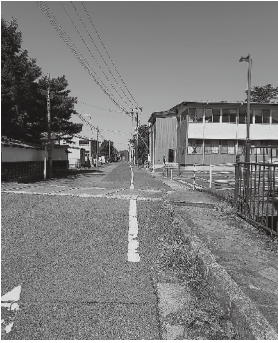
カラー舗装工事を行う道路
