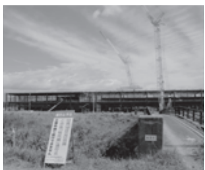
ウェルファムフーズ 工場建設地
