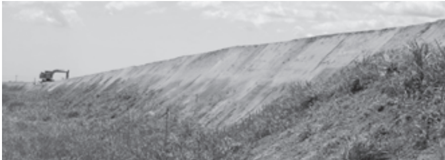
整備中の出来川堤防
