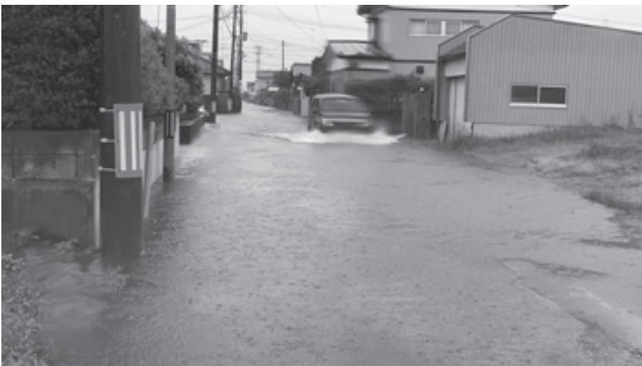
内水により冠水した町道
