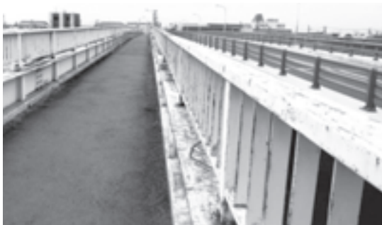
涌谷大橋の歩道
