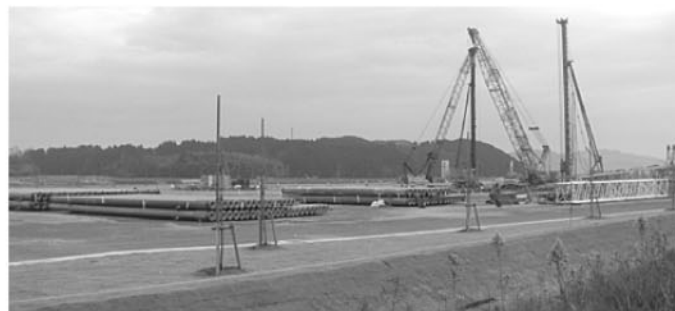
株式会社ウエルファムフーズ新工場建設地
