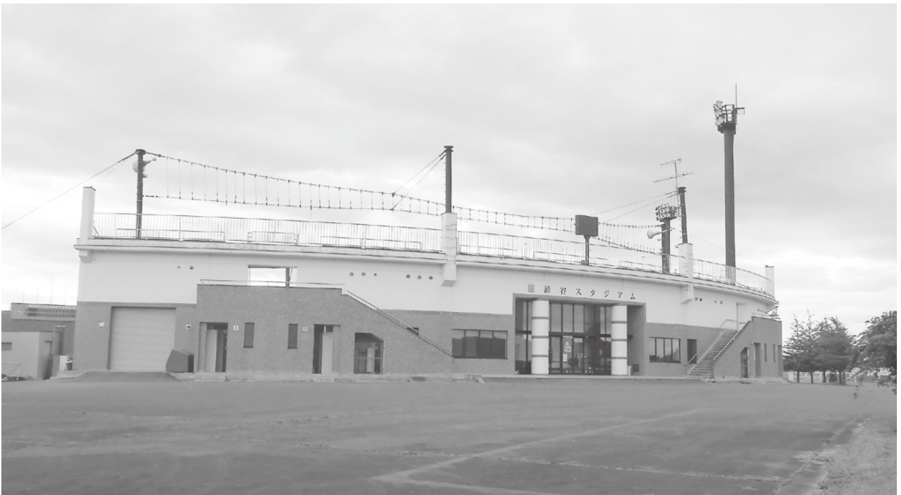
涌谷スタジアムは地下排水溝による排水が良く、ナイター設備が整っているほか、駐車場も広いです
