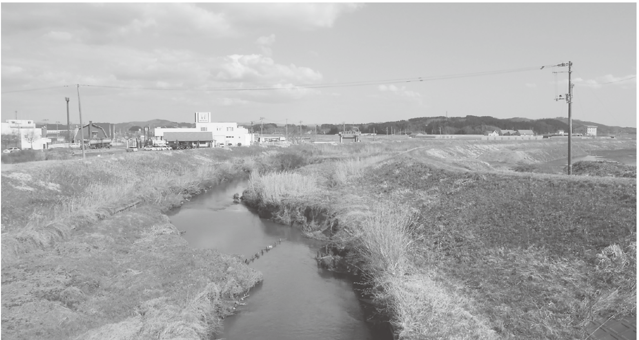
毎年のように各地で発生する洪水、冠水被害 河川の氾濫を防ぐためにも、築堤工事の推進と、防災対策が急務
