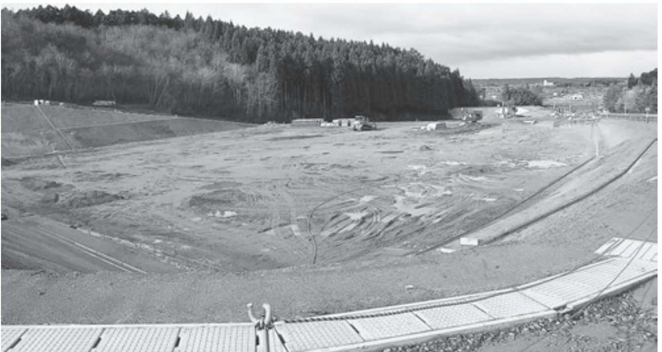
完成間近な黄金山工業団地
