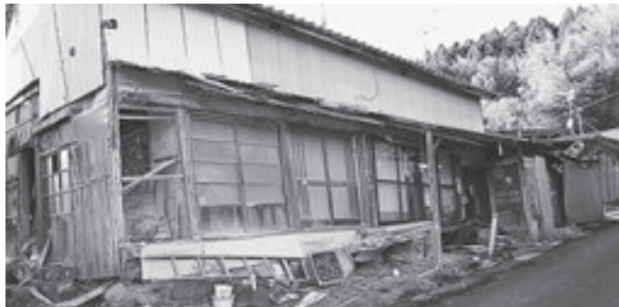
ようやく解体 (日向住宅)
