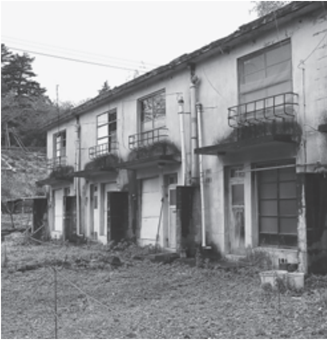
解体撤去を急げ（沢住宅）
